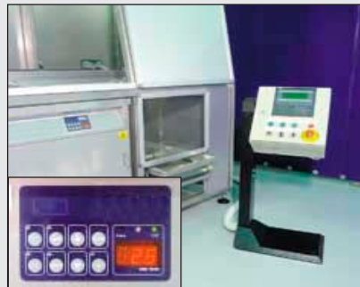
SPS - Steuerung mit Steckverbindungen / Bedienpaneel mit Display
